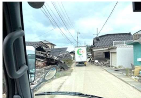
地震による瓦礫や傾いた家屋
