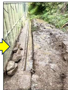
約5時間の作業で土砂で埋まっていた溝がきれい
